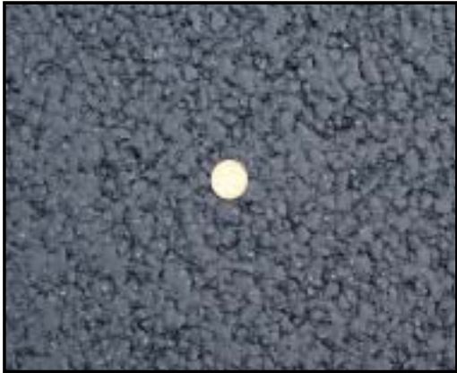
Figure 2 : Texture du SMA sur l'autoroute 20
