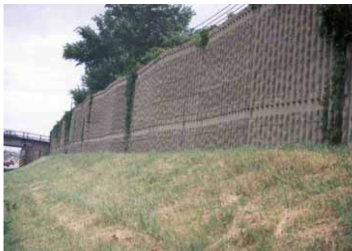
Écran réalisé avec des fibres de bois
