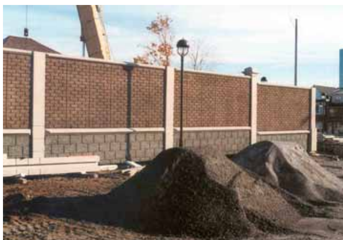
Écran réalisé avec un schiste expansé
