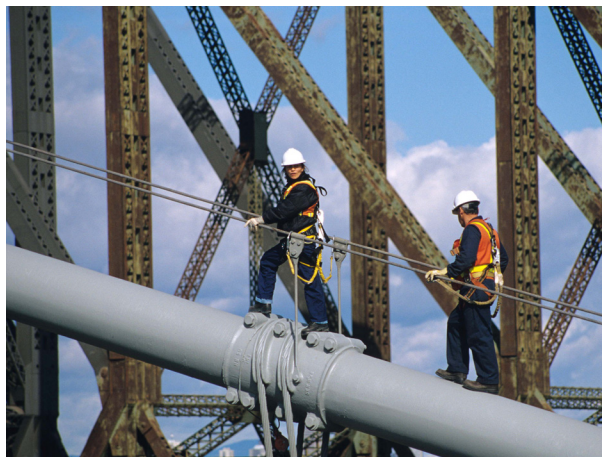
P-04296 Inspectrice et inspecteur circulant sur les câbles porteurs du pont Pierre-Laporte
