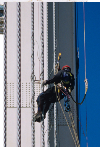
Inspection en appui sur cordes
