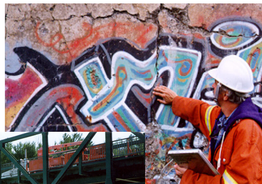
Inspection « le doigt sur la pièce »
